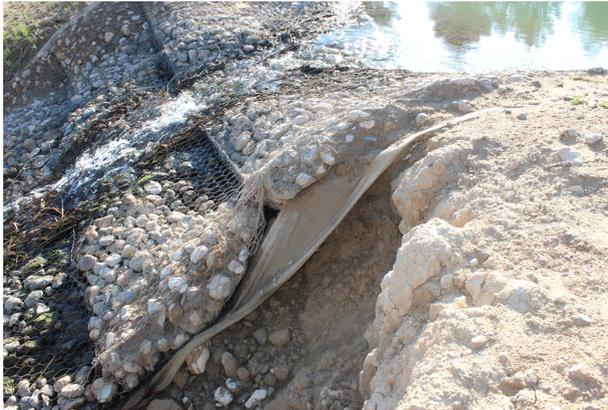
Figura 1.2: Socavón lateral de un aliviadero de gavión
