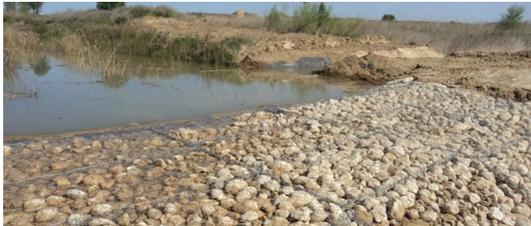
Figura 1.1: Coraza de gavión con derivación
